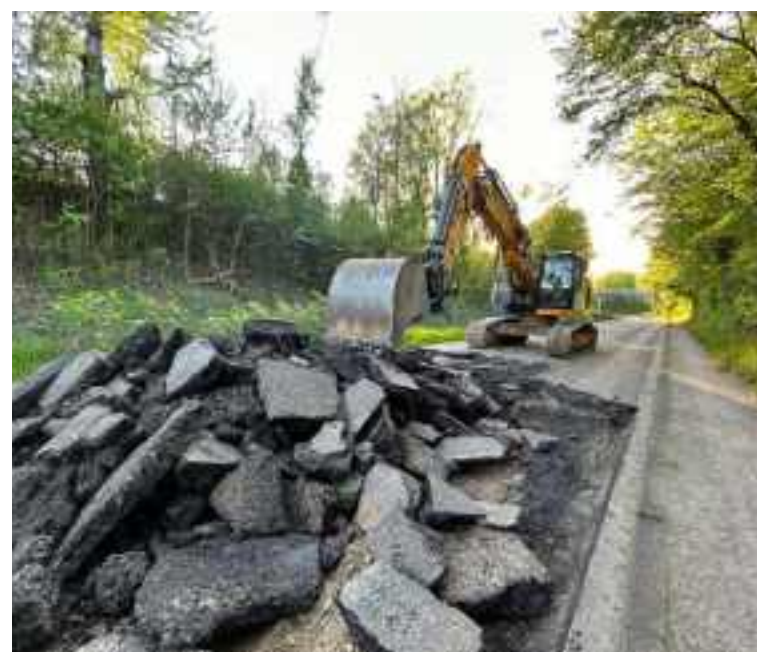
Die Arbeiten an der Großbaustelle zwischen Steinbach und Neuweier haben begonnen
